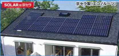
太陽光発電システム (3.84kW) ※坪数・屋根形状等により容量は異なります。 太陽光発電モニター
